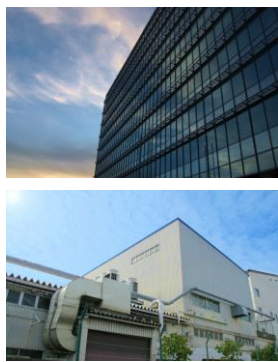
エネルギー監視
